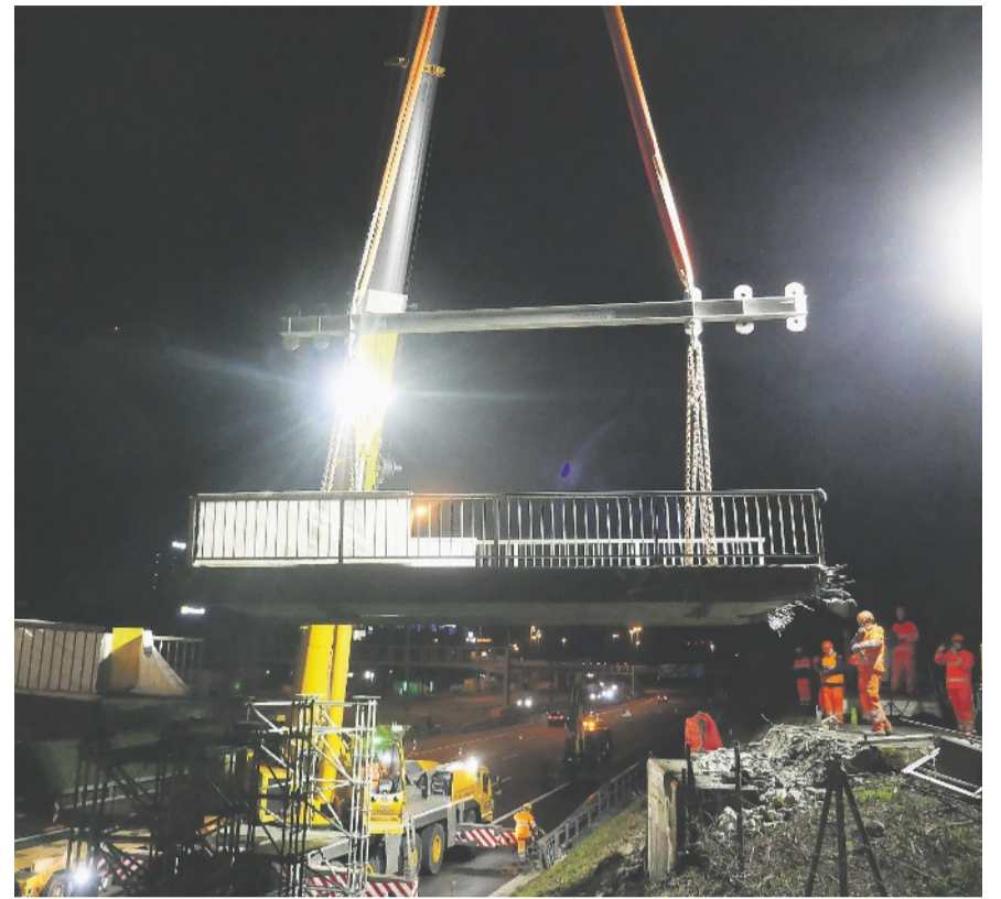
Verbindung für Fussgänger über die Autobahn zwischen Schwamendingen und Wallisellen: Am Montagabend wurden erste Teile der alten Personenüberführung abgebrochen. BILD EBE
