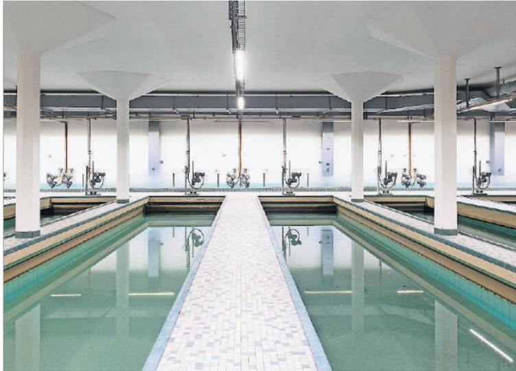
Schnellfilter im Seewasserwerk Lengg zur Trinkwasseraufbereitung.
